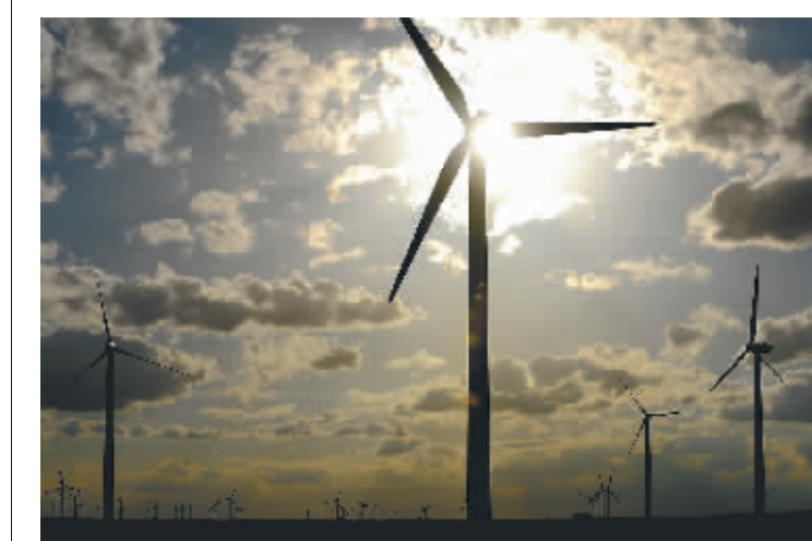
这是已经部分建成的锡林郭勒盟辉腾梁风电场(摄于2008年6月23日)。随着一批新的风力发电项目建成运行,至2008年10月底内蒙古已投产的风力发电机组总规模达到205.68万千瓦。新华社记者 任军川 摄
