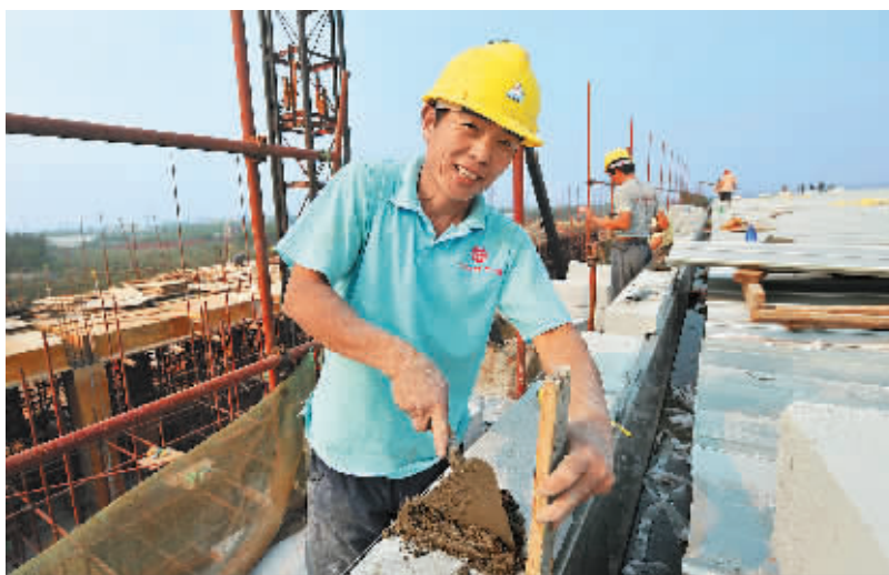
3月24日,澄迈老城开发区海南统一企业有限公司热灌装饮料生产线项目工地,工人们正在加紧厂房棚顶施工。
